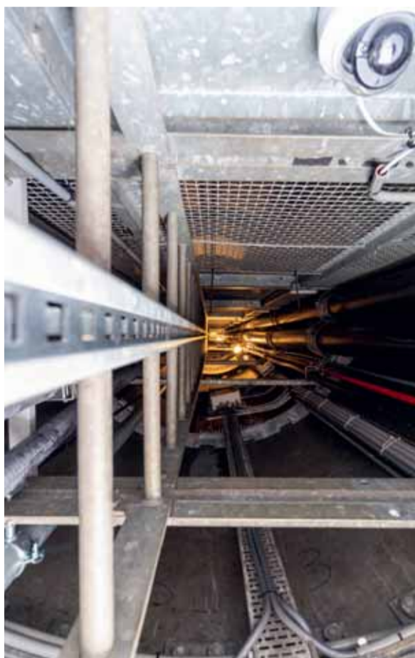
Omdat de diameter van de mast maar 2 meter is, is het leidingwerk in stukken van 2 meter naar de platforms gebracht en ter plekke gemonteerd.
